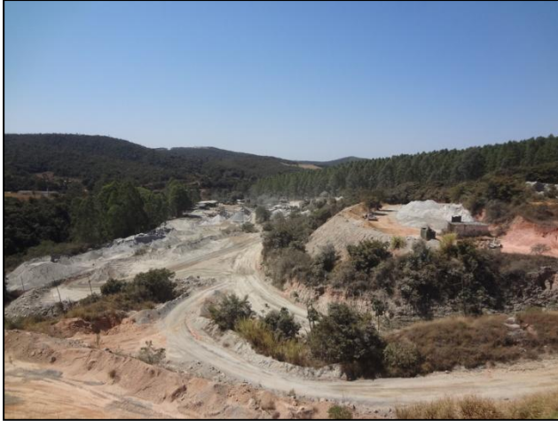
Foto 01 – Vista geral do empreendimento (VISTORIA SUPRAM/LM - 04/09/2019).
