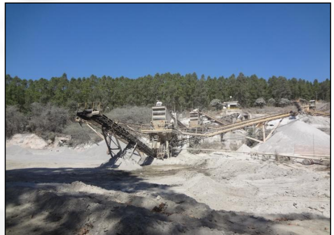
Foto 04 – Vista parcial da unidade de britagem (VISTORIA SUPRAM/LM - 04/09/2019). Nota-se cortinamento arbóreo ao fundo.
