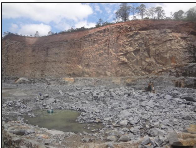
Foto 11 – Frente de lavra (VISTORIA SUPRAM/LM 11/11/2020). Ao fundo, observa-se paredão rochoso que limita a propagação dos ruídos e vibrações gerados na operação da extração mineral.
