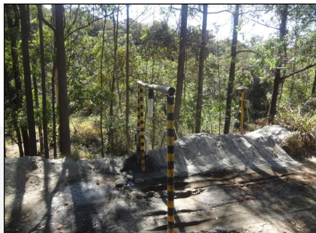
Foto 10 – Ponto de abastecimento de água do caminhão-pipa (VISTORIA SUPRAM/LM - 04/09/2019).
