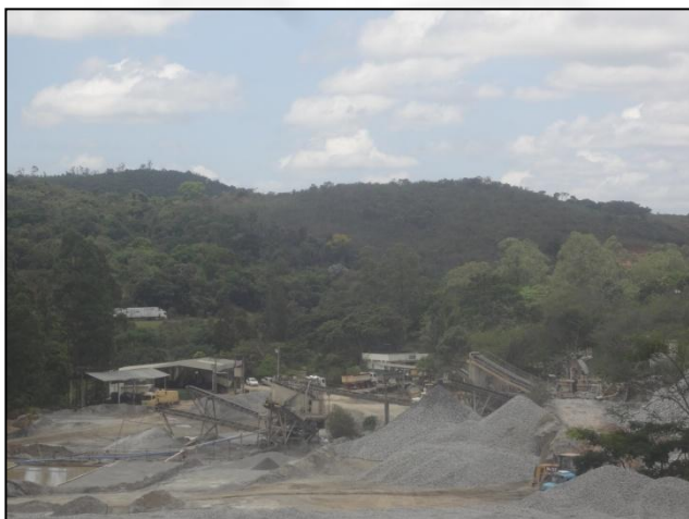
Foto 12 – Vista geral da unidade de britamento (VISTORIA SUPRAM/LM 11/11/2020). Ao fundo, observa-se veículo de carga transitando na BR 381.
