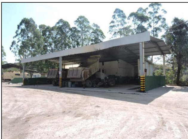
Foto 09 – Oficina para manutenção de máquinas e equipamentos (BELMONT - 2019).
