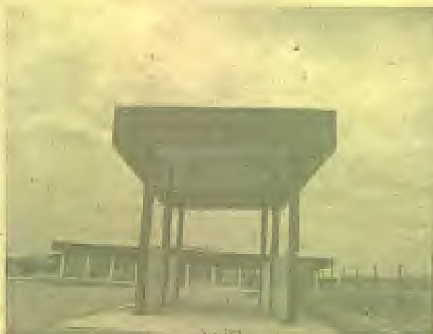
Foto 03. Área de lavagem de veículos
