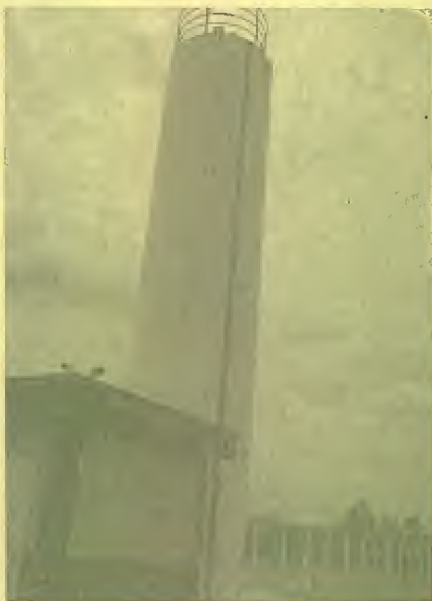
Foto 09. Armazenamento de água
