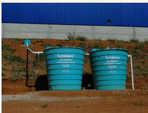
Figura 14 – Sistema Fossa Séptica – Filtro Anaeróbio
