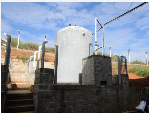
Figura 13 – Tanque reservatório de resina utilizada no plastsol
