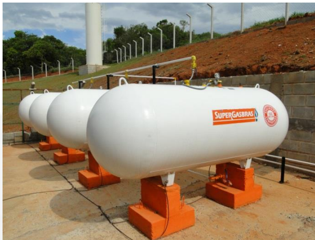
Figura 12 – Base de armazenamento de GLP
