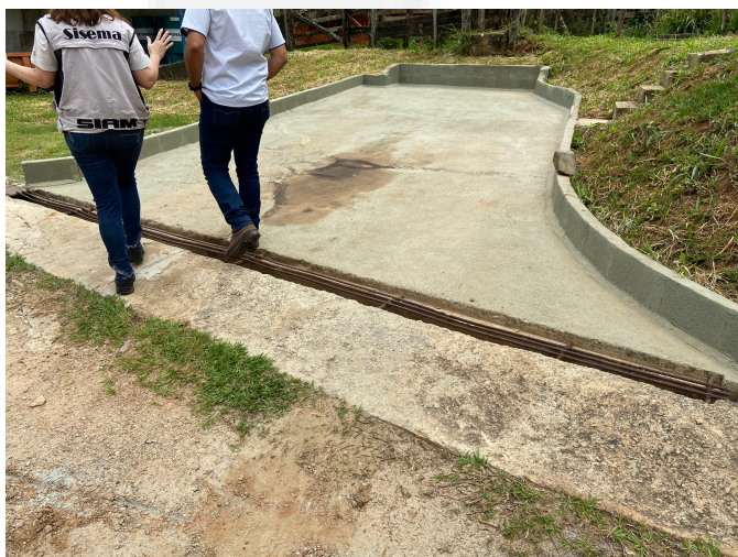
Foto 03: Área de abastecimento de veículos dotado de piso impermeabilizado e canaletas direcionando o fluxo para caixa SAO.
