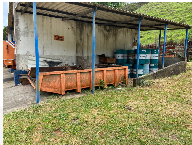
Foto 06: Área de armazenamento de resíduos coberta com piso impermeabilizado e canaletas direcionando o fluxo para caixa SAO.
