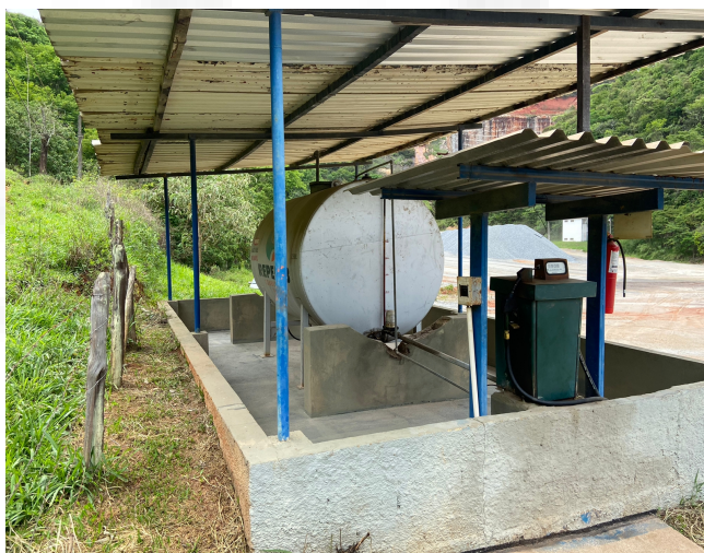
Foto 04: Tanque aéreo de abastecimento com as medidas de controle e mitigação de impactos implantadas.
