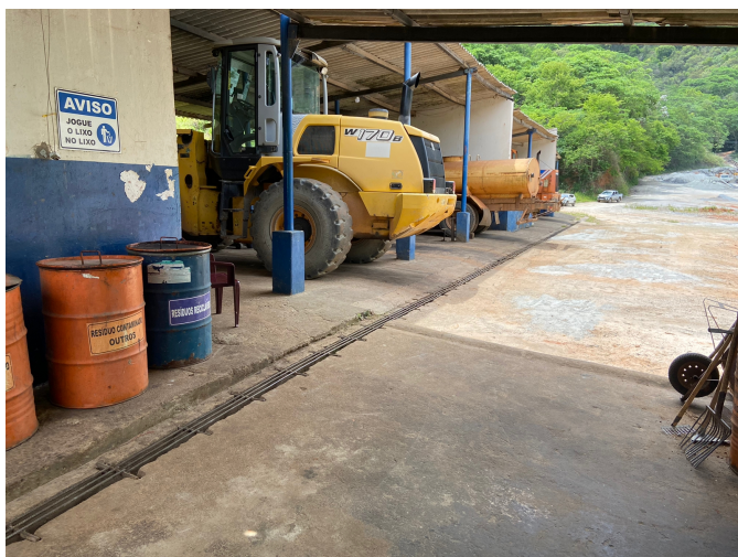
Foto 05: Galpão de armazenamento de equipamentos coberto dotado de piso impermeabilizado e canaletas direcionando o fluxo para caixa SAO.
