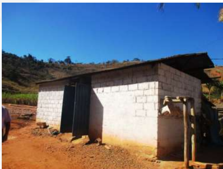
Figura 5 – Serralheria utilizada no empreendimento.
