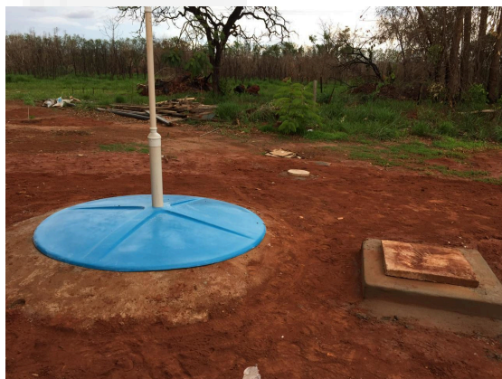
Foto 03. Sistema de tratamento de efluentes sanitários
