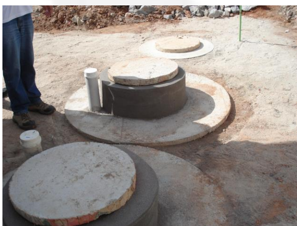
Nova ETE sanitária instalada
