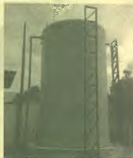
Foto 16. RAFA – Reator anaeróbico de fluxo ascendente.
