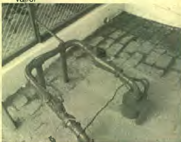
Foto 08. Poço tubular com hidrômetro instalado.
