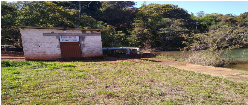
Casa de Máquinas para Captação Coletiva
