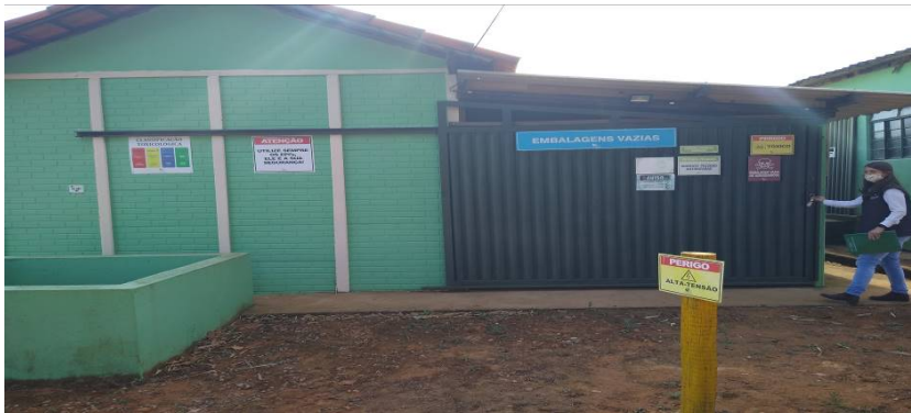
Entrada de depósito de Agrotóxicos com Placas Indicativas
