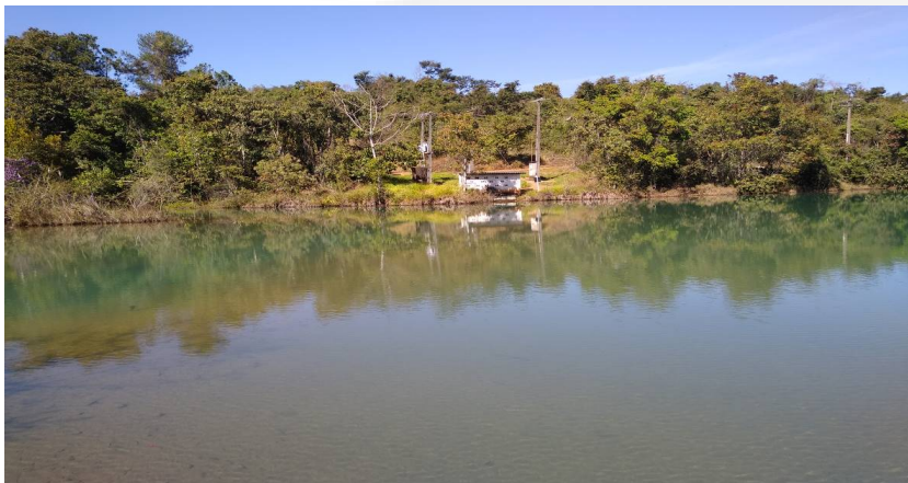
Barramento e Casa de Máquinas
