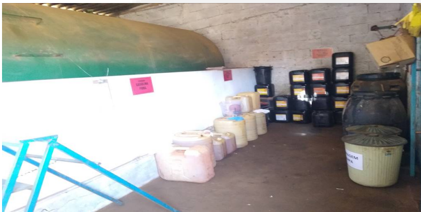
Tanque de combustível e depósito de Óleos Lubrificantes.
