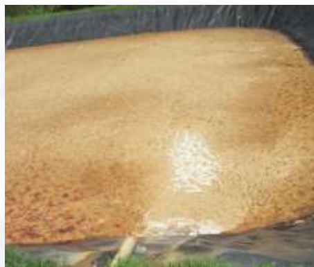
Figura 06: Tanque de equalização
