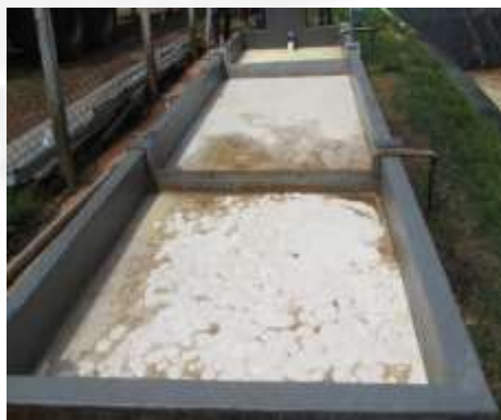
Figura 05: Caixa de separação de gordura
