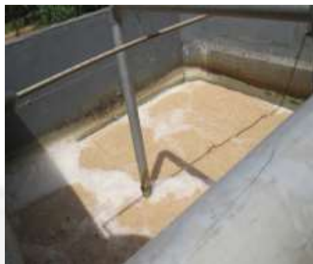
Figura 08: Reator biológico aerado
