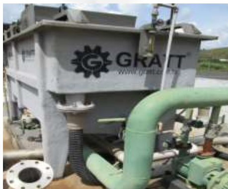
Figura 07: Flotador
