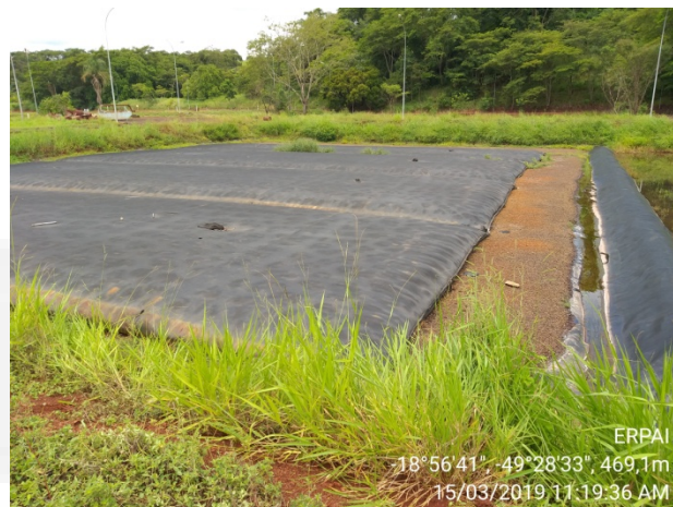
Figura 6: Tubos geotêxteis contendo lodo desidratado.
