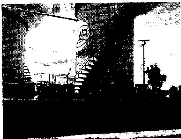
Foto 01. Tanque aéreo de 90 m 3 , onde será armazenado óleo diesel.
