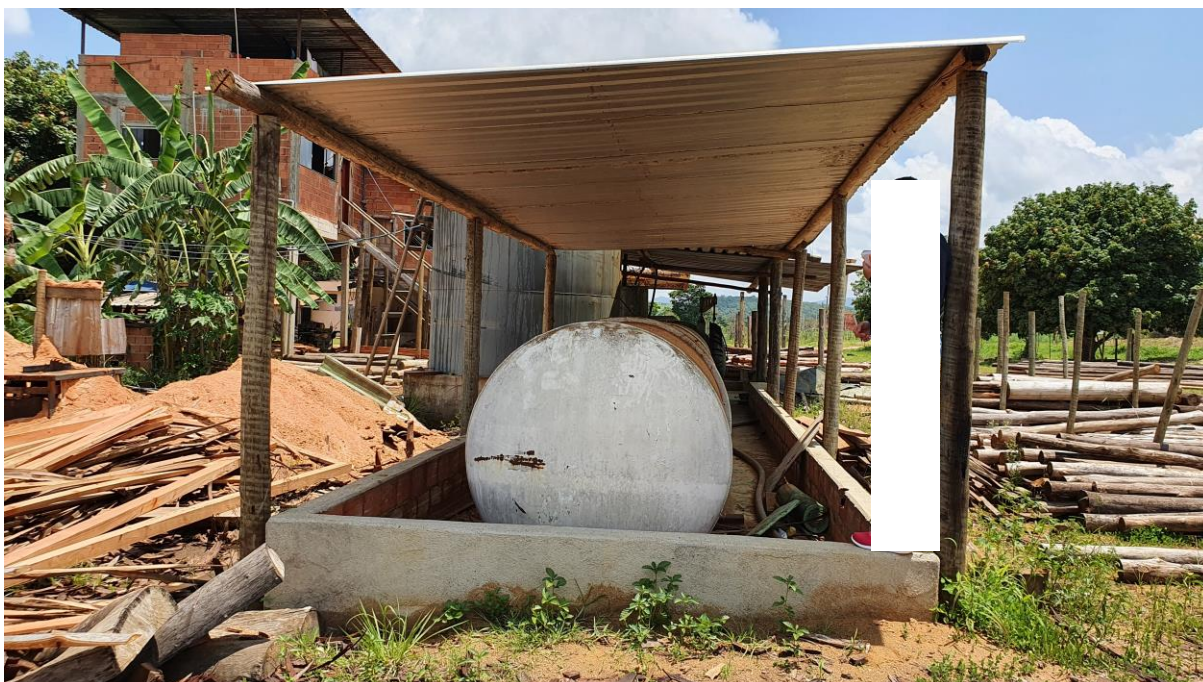
Figura 05: Autoclave instalada dentro da bacia de contenção e cobertura de telha de amianto.
