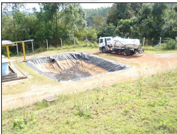
Foto 15. Bacia de recepção de água pluvial.
