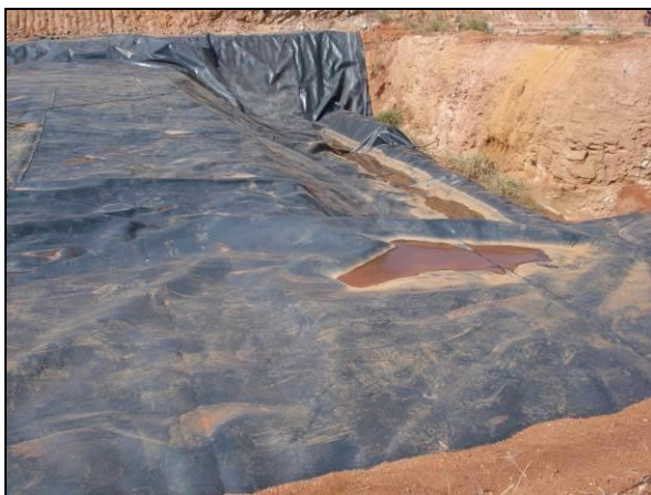
Foto 13. Célula em operação com manta PEAD.
