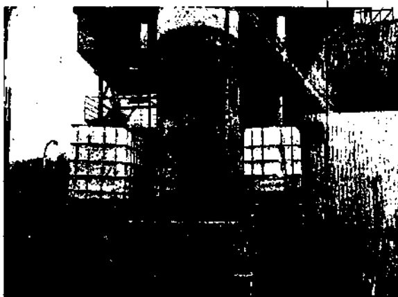
Foto 03. Reservatório de aditivos dentro de bacia de contenção
