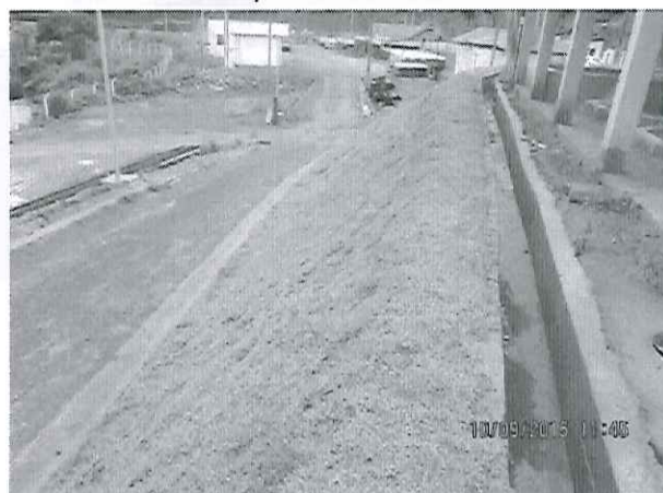
Foto 10. Estruturas de drenagem e taludes recuperados.
