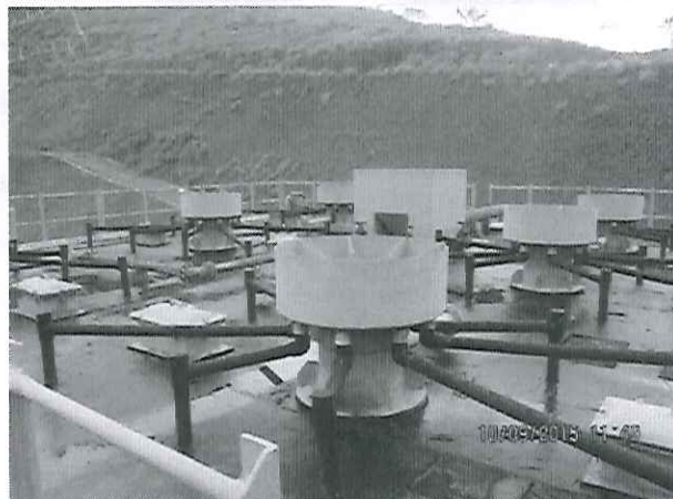
Foto 08. Vista superior do reator UASB.
