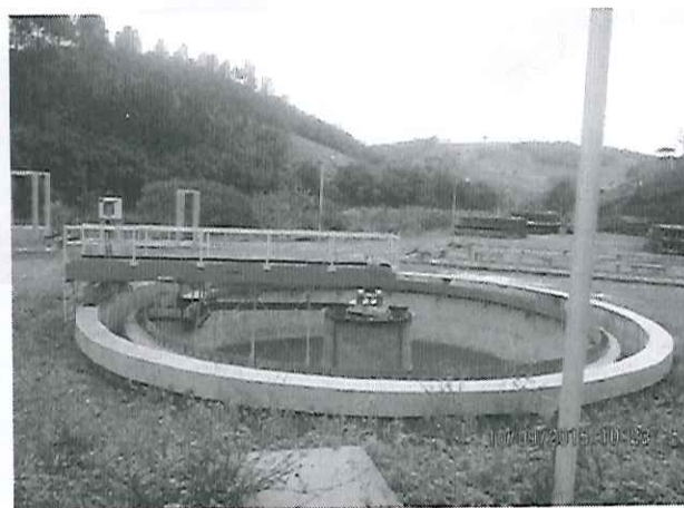
Foto 04. Decantador secundário implantado.
