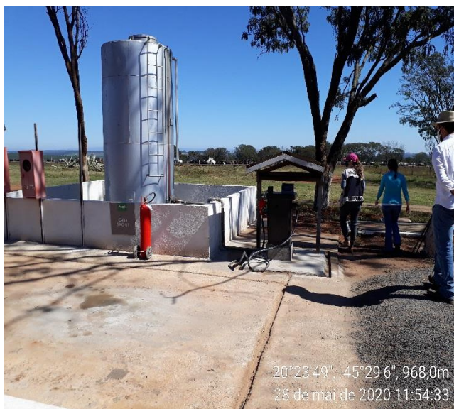
Foto 04: Tanque de abastecimento e Caixa
