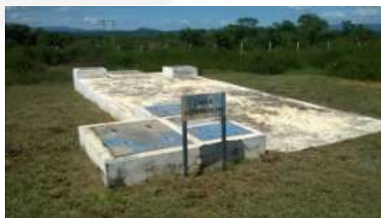
Foto 2. Caixa Separadora de Água e Óleo
