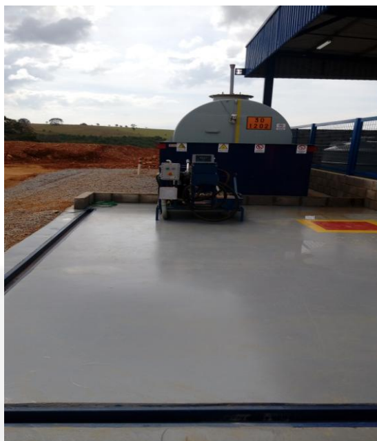
Pista de abastecimento impermeabilizada, com bomba, tanque aéreo e bacia de contenção.
