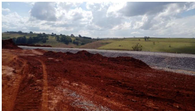
Área da pilha de estéril com sistema filtro-drenante ao fundo.
