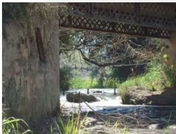
Foto 01. Local de implantação do barramento
