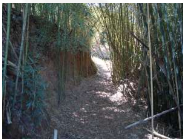
Foto 03. Área de construção do conduto
