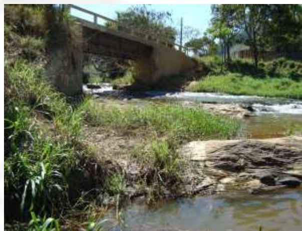
Foto 02. Região da Tomada d'água
