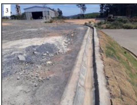
Imagem 1: Visão superior da área, aonde pode ser vista a canaleta/sarjeta meia cana, identificada pela seta vermelha na imagem.
