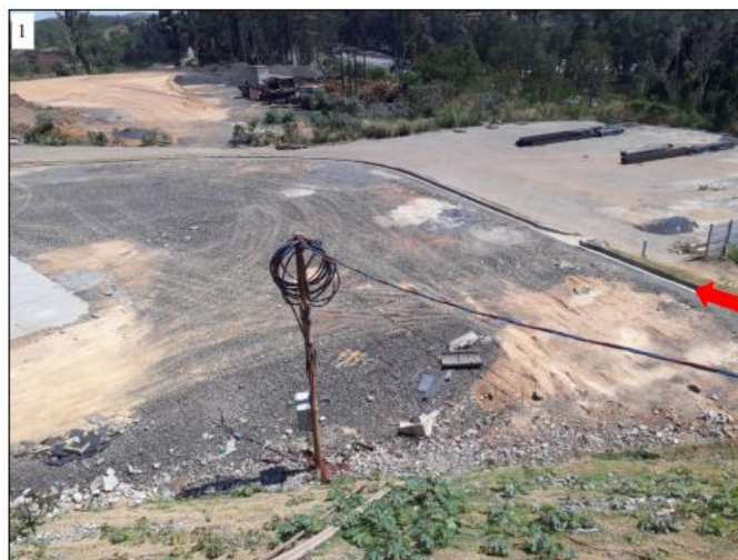
Imagem 1: Visão superior da área, aonde pode ser vista a canaleta/sarjeta meia cana, identificada pela seta vermelha na imagem.
