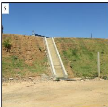
Imagem 5: Escada hidráulica para descida da água em degraus, facilitando seu escoamento, visto o terreno declivososo.
