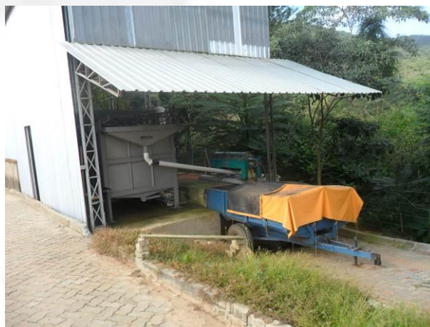
Foto 02. Estação de Tratamento de efluentes Industriais
