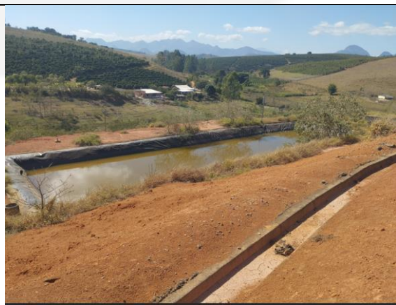
Figura 07: Lagoa facultativa do sistema de tratamento dos efluentes percolados do aterro.
