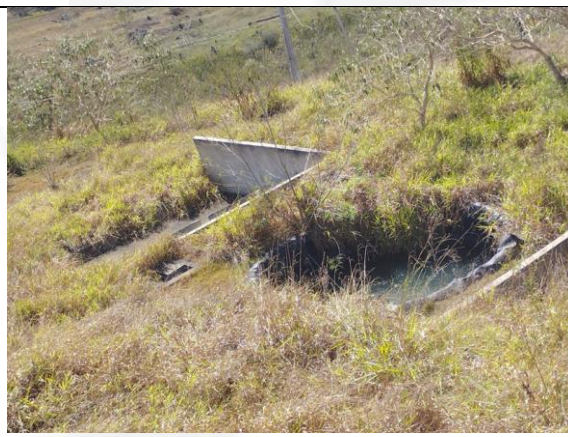
Figura 08: Lagoa anaeróbia e sistema de escada de aeração.
