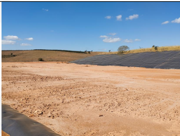
Figura 06: Vista panorâmica da 1ª plataforma do aterro sanitário, com a manta de PEAD instalada e com a base coberta por terra.
