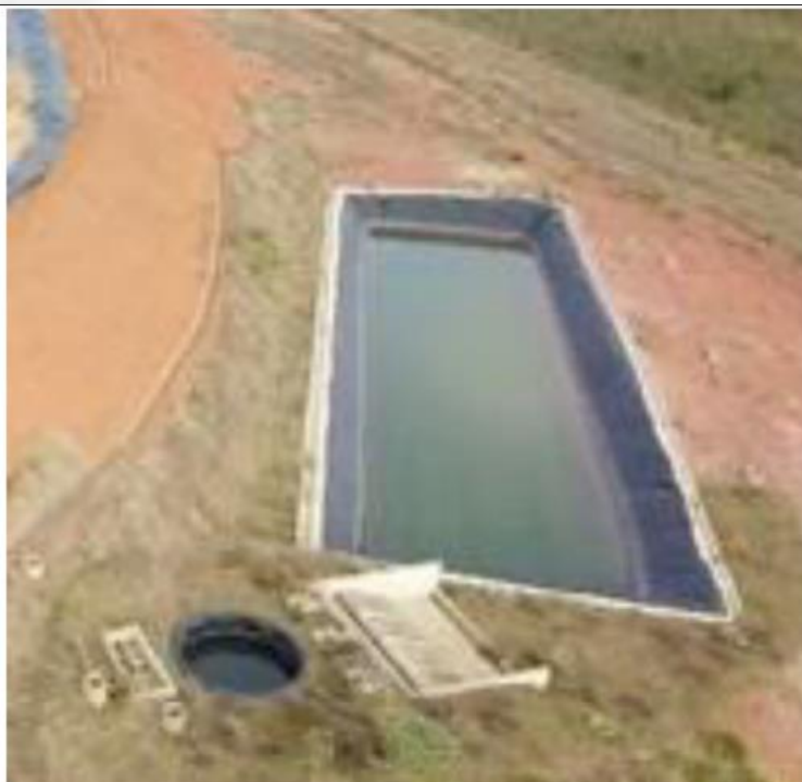
Figura 09: Estação de Tratamento de Líquidos Percolados (ETLP) implantada na gleba do aterro sanitário, contemplando caixas de entrada e medição de vazão, lagoas de estabilização e cascata de aeração. Fonte: Estudos ambientais RCA.
