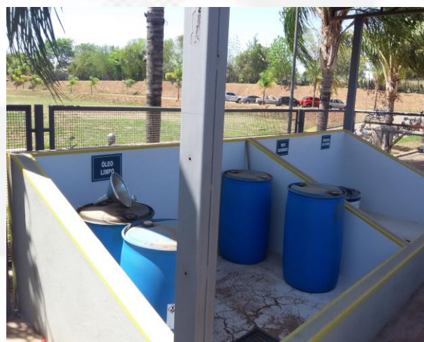
Foto 10 – Depósito de Resíduos oleosos
