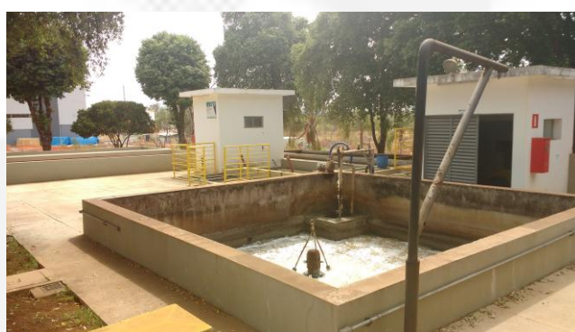
Foto 4 – Estação de Tratamento de efluentes
