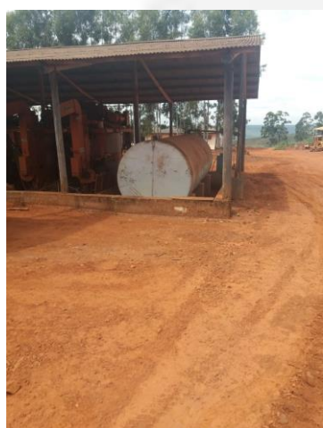
Foto 13: Tanque aéreo de combustível e Área de abastecimento.
