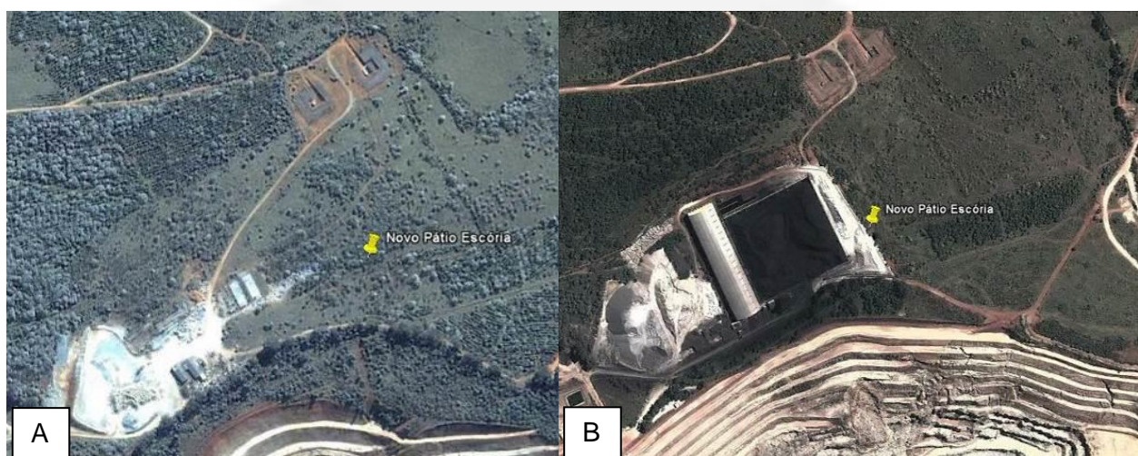
Figura 04: Detalhe da área requerida para implantação do novo pátio de armazenamento de escória siderúrgica antes (A) e após a intervenção (B).
