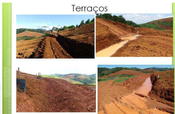
Figura 10: Mostra um trator construindo um terraço, terraços construídos e retendo água pluvial. Fonte: Votorantim - CBA
