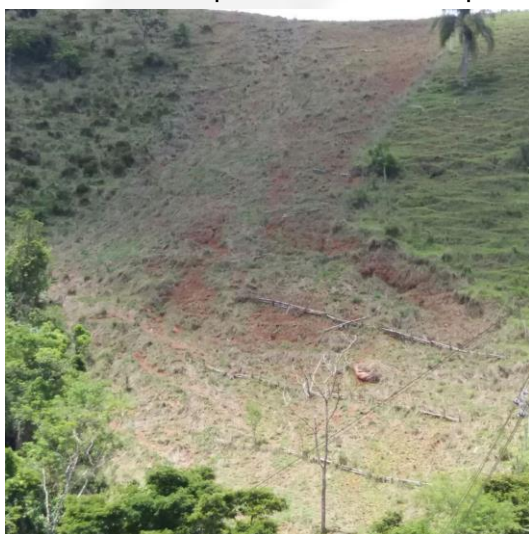
Figura 14: Execução de paliçadas e plantio de gramíneas na descida do conduto de alta pressão.
