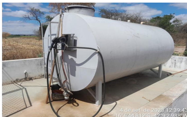
Foto 7 - Tanque de abastecimento (diesel)
