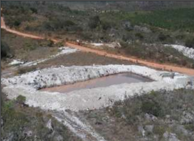
Foto 13: Bacia de decantação e recuperação água.
