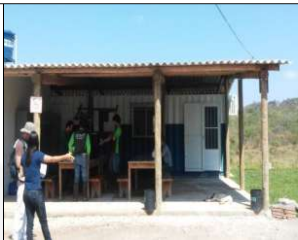
Foto 06: Estrutura de apoio.
