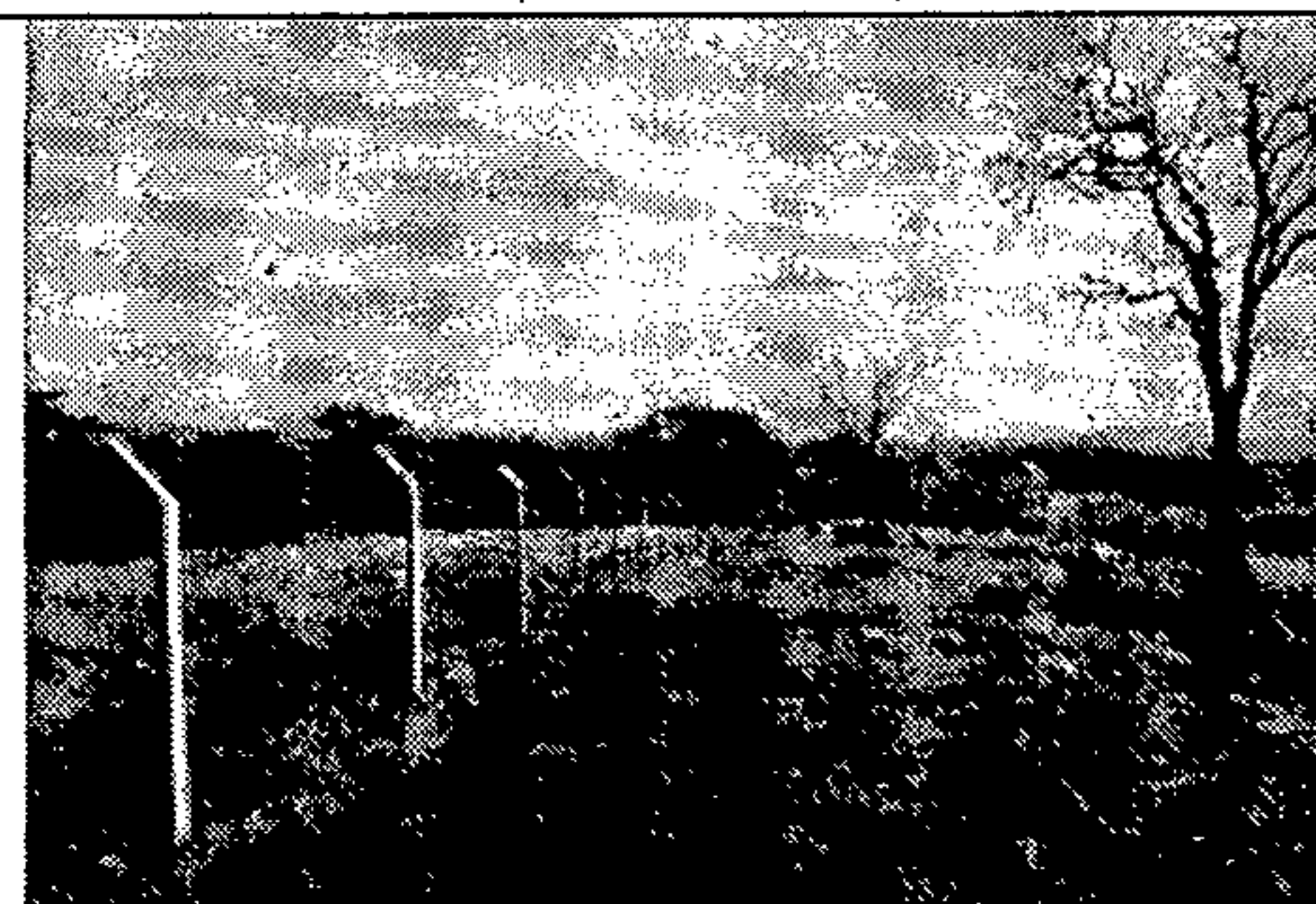
Foto 01. Vista do alambrado construído. Fonte: RADA, 2010.
