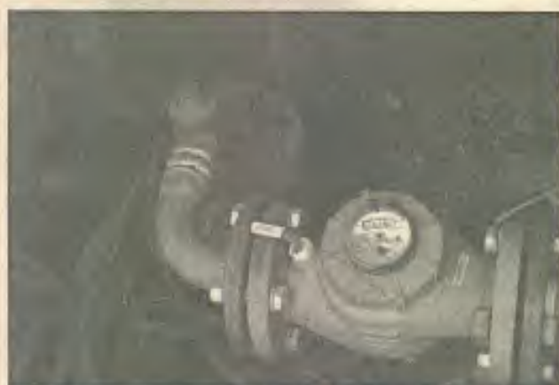
Foto 15. Hidrômetro no poço de captação de água
