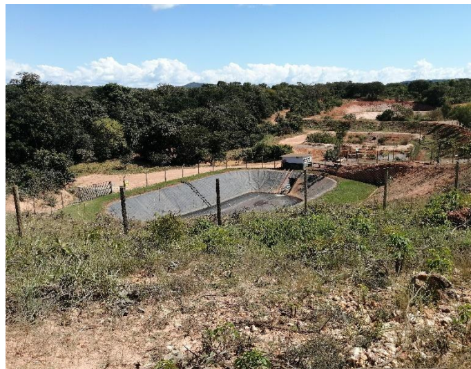
Foto 4: Lagoa de Acumulação e Bombeamento de Chorume
