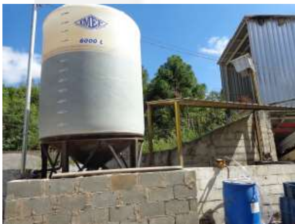
Foto 09. Dique de contenção de aditivos.
