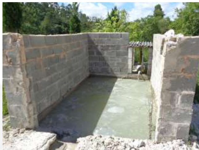
Foto 04. Reservatório de efluentes provenientes do bate lastro.
