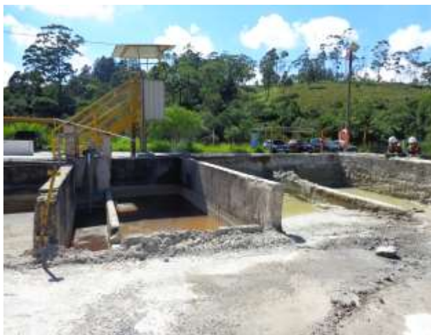
Foto 03. Sistema de decantação – bate-lastro.
