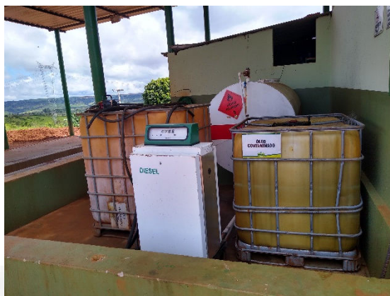
Tanque de abastecimento e ao lado direito, de armazenamento de óleo queimado
