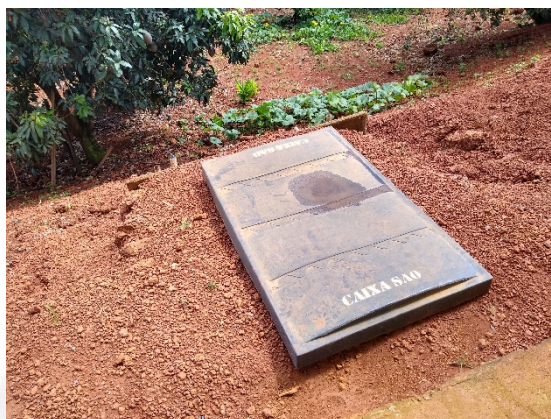
Caixa SAO do lavador e abastecimento de veículos
