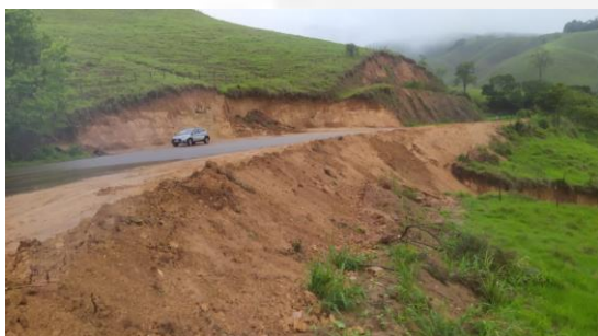
Foto 5: Local onde o asfalto cedeu/objeto de reparação.
