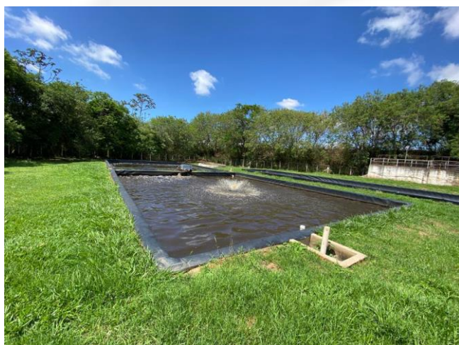
Foto 9: Lagoas aeróbias aeradas com o respectivo filtro clorador na entrada
