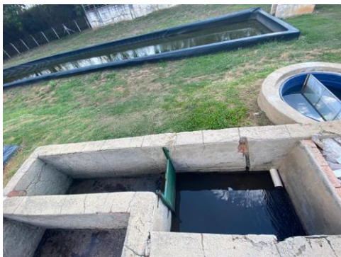
Foto 7: Entrada do efluente para o sistema de gradeamento
