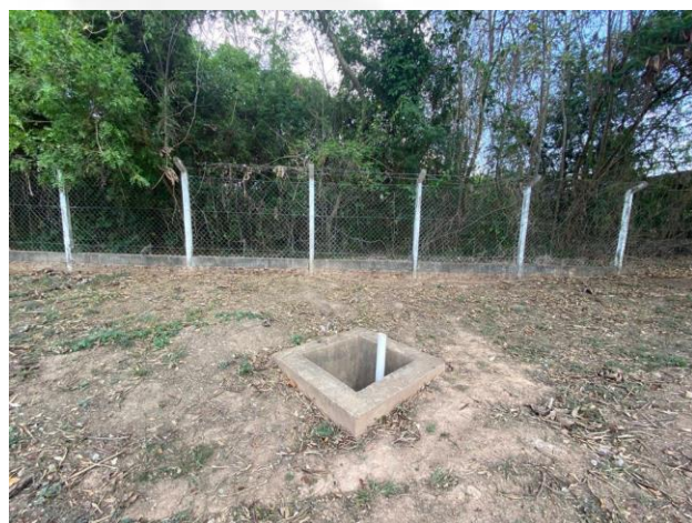
Foto 11: Caixa de passagem com filtro clorador na saída
