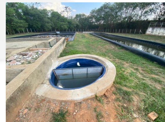
Foto 6: Entrada no efluente na ETEI onde passa pela peneira estática
