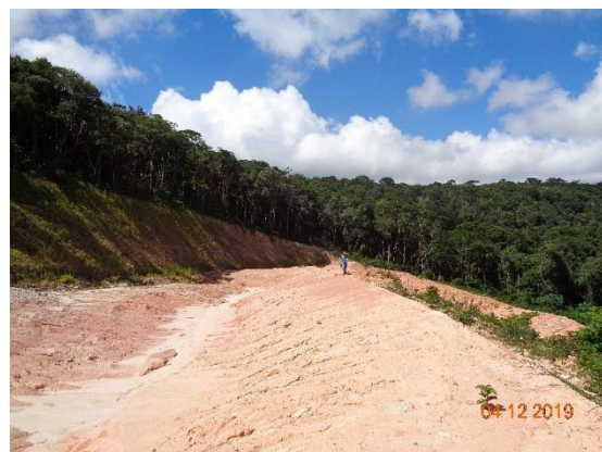
Foto 04. Vista da parte superior da cava, onde foi feita a supressão de vegetação e decapeamento da jazida.
