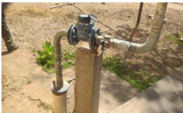
Foto 03. Poço Tubular
