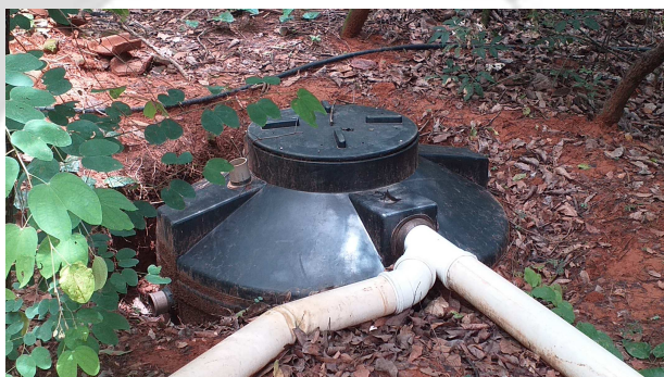
Imagem 04: Fossa biodigestor instalada na propriedade.
