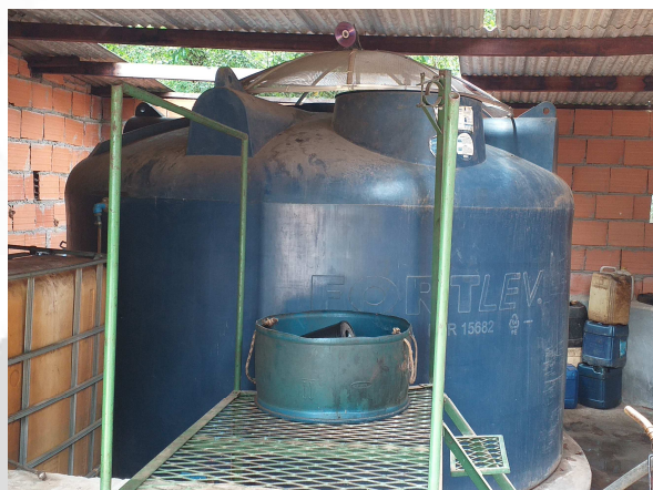
Imagem 05: Tanque de abastecimento e produtos contaminados em bacia de contenção.
