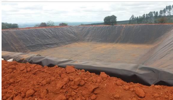
Foto 06: Reservatório de água pluvial.
