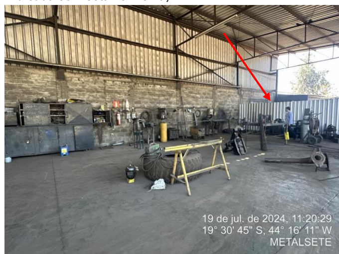
Figura 5. Vista interna da oficina, com divisão metálica indicada com seta vermelha;
