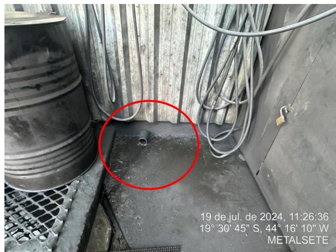
Foto 42: Conexão da área de resíduos classe I até a CSAO associada;
