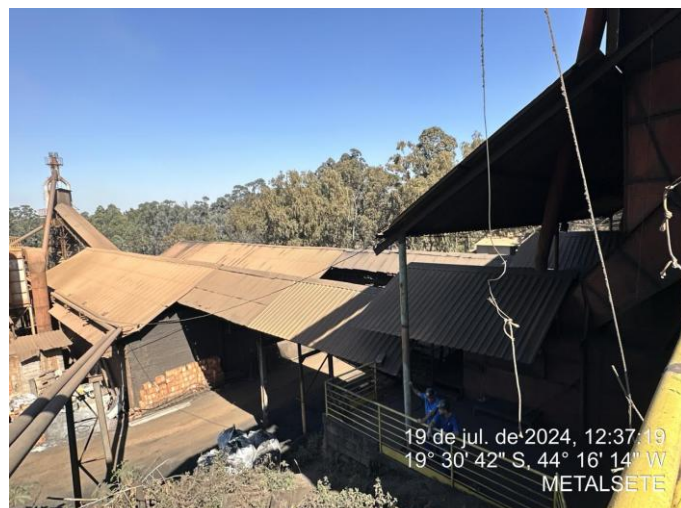
Foto 16: Vista da correia transportadora que leva o carvão para ser incorporado ao sistema do alto-forno;
