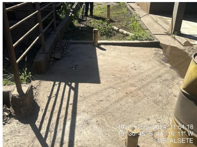
Foto 46: Fossa associada ao almoxarifado e à sala da segurança do trabalho
