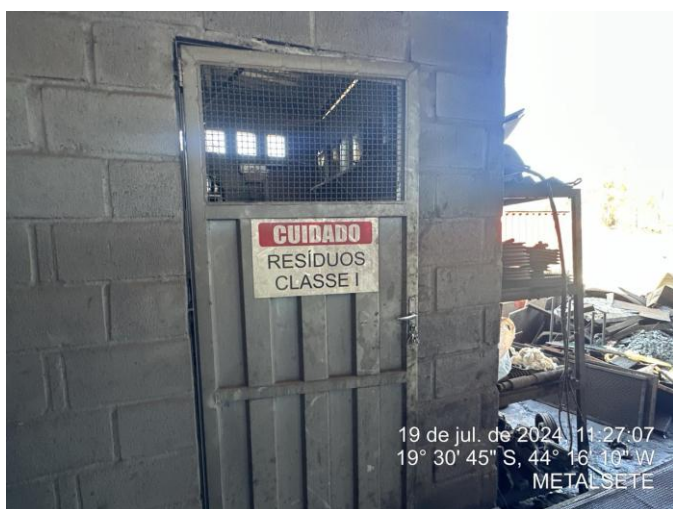
Foto 41: Local de armazenamento de resíduos classe I;
