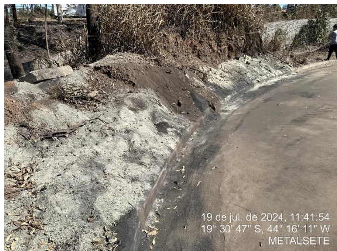
Foto 28: Canaleta próxima à área da bacia de decantação e ao tanque de pó de balão;
