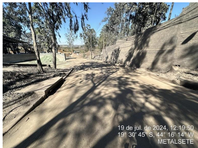
Foto 30: Canaletas na via de acesso principal do empreendimento;
