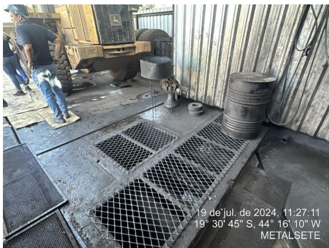
Foto 45: CSAO associada às oficinas e ao local de acondicionamento dos resíduos perigosos (classe I);
