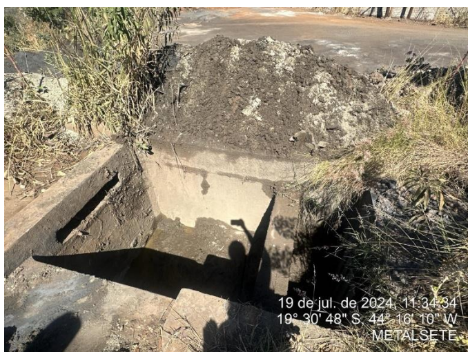
Foto 35: Caixa de decantação de sedimentos próxima ao pátio de minério, evidenciando possível limpeza, com acúmulo de resíduos dispostos em sua lateral;
