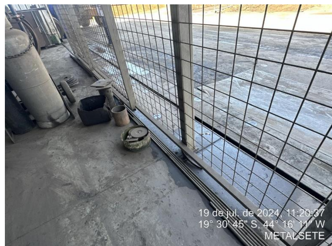
Foto 52: Canaleta que circunda a oficina, próxima a oficina mecânica;
