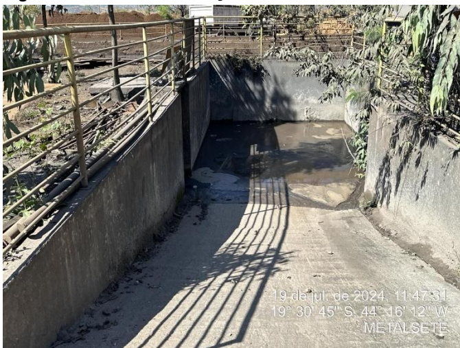
Figura 14. Bacia de decantação
