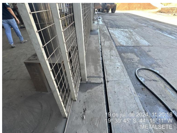
Foto 51: Canaleta que circunda a oficina, na frente da oficina industrial;
