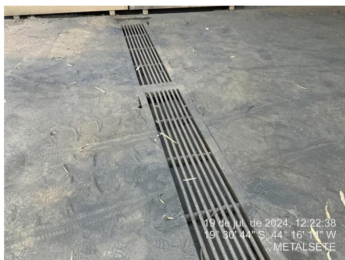
Foto 29: Canaleta próxima ao alto-forno;
