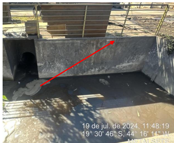
Foto 32: Guarda-corpo da bacia de decantação
