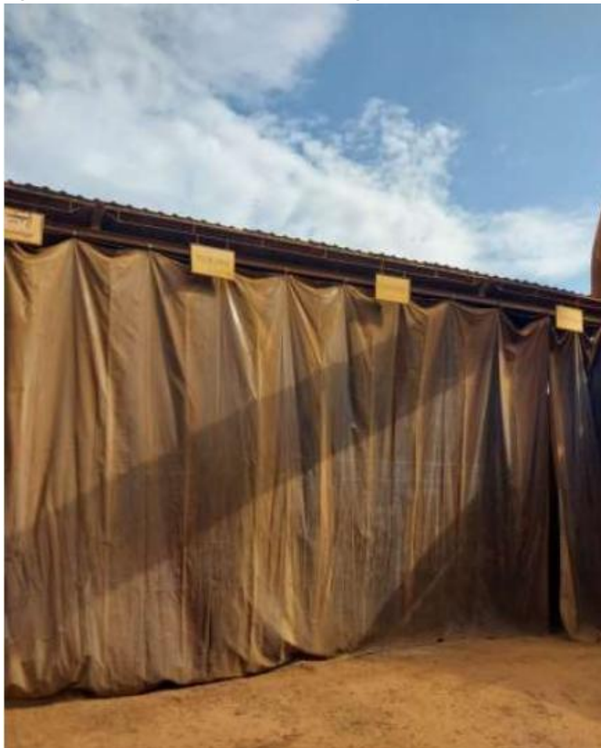
Figura 18. Enclausuramento da área de carregamento de minério e fundentes
