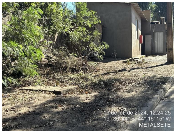
Foto 48: Fossa associada à portaria e prédio administrativo;
