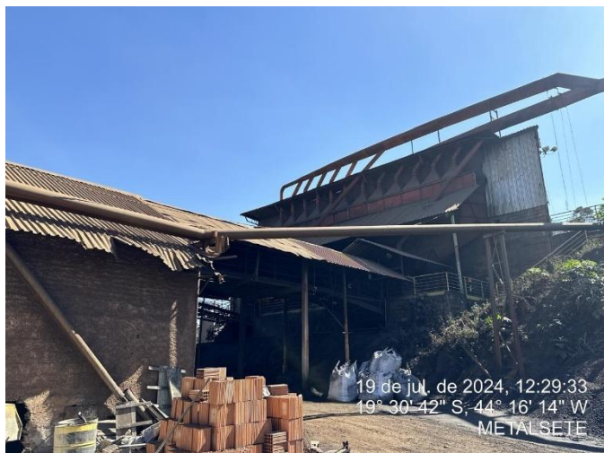
Foto 13: Galpão de carvão - -- com algumas obras de melhorias na parte externa;
