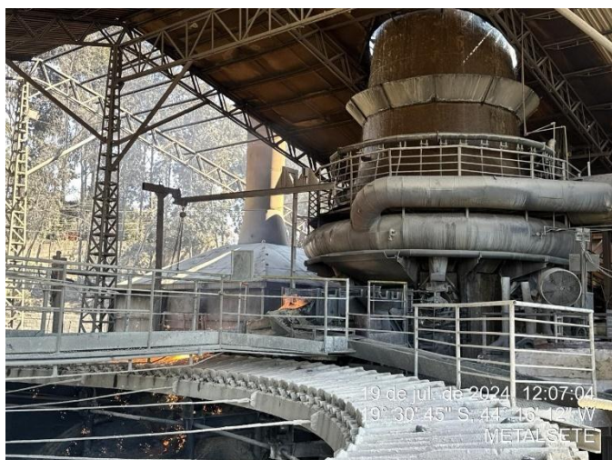
Foto 9: Rodeio associado ao alto-forno;
