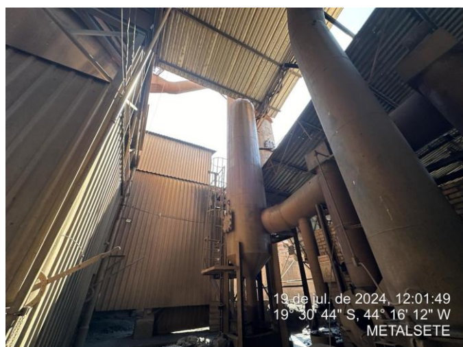
Foto 5: Lavador de gás (as estruturas do alto-forno são visíveis no fundo)
