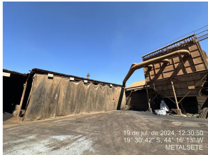
Foto 18: Alimentação do alto-forno. Lona na frente para conter os
