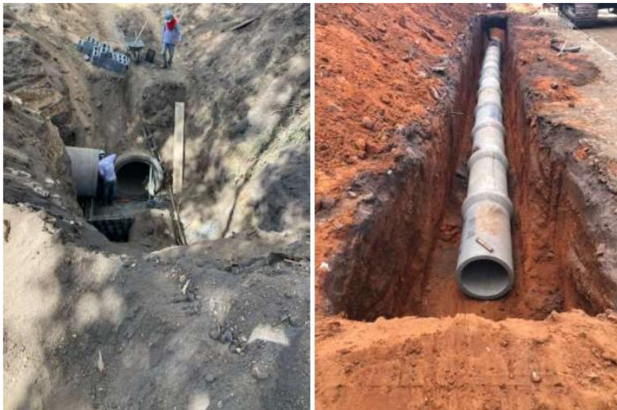
Figura 12. Manilhas instaladas em todo o parque industrial
