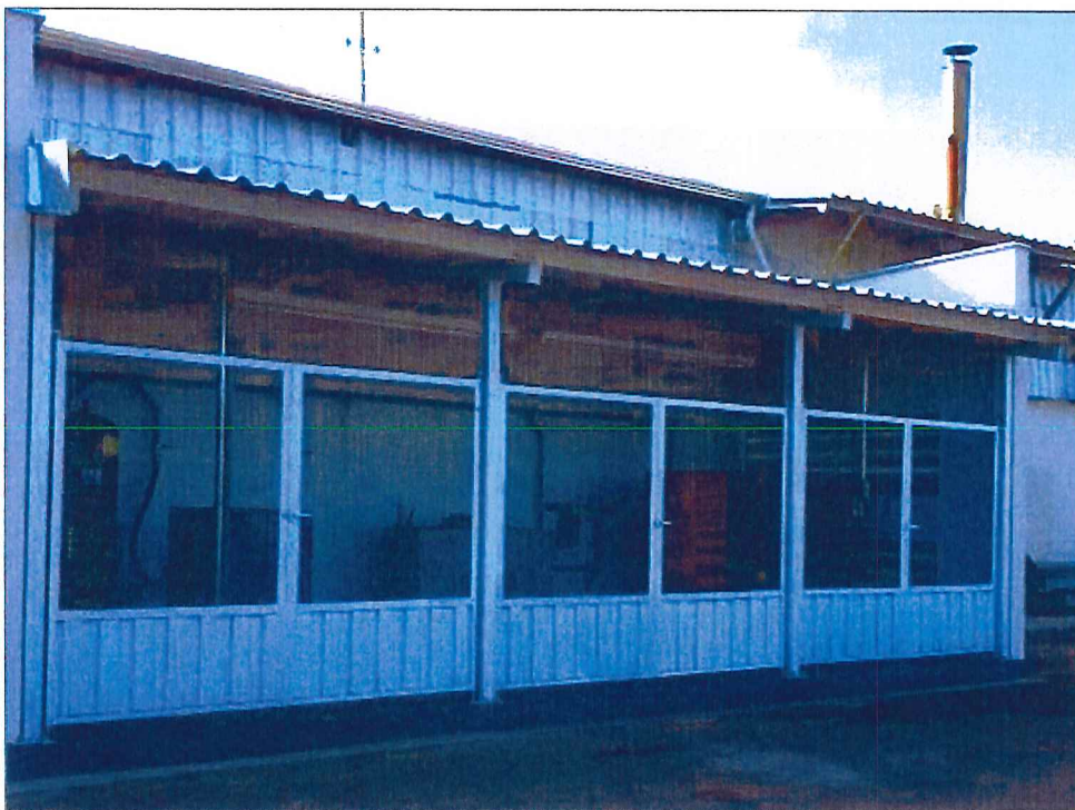
Figura 7. Utilidades – Sala dos compressores de ar antes da desativação industrial.
