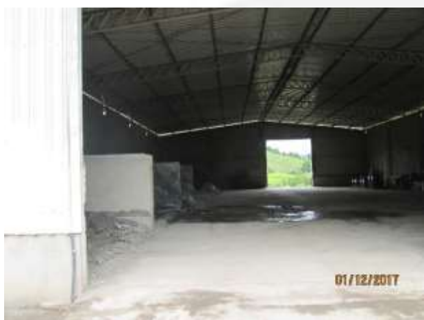
Foto 01. Galpão de armazenamento. Resíduos aguardando transporte para destinação final na unidade de Betim.
