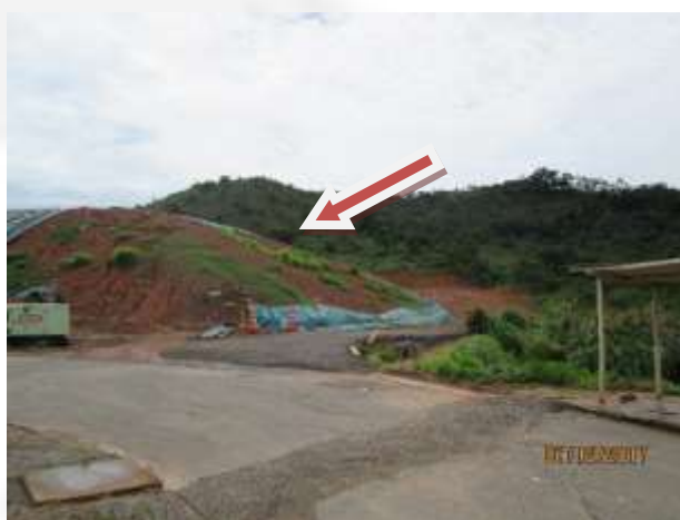
Foto 02. Aterro de resíduos classe I em fase de cobertura final.
