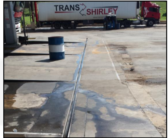
Foto 02. Detalhe da canaleta de drenagem na pista de abastecimento.
