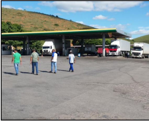
Foto 01. Vista Geral do posto.
