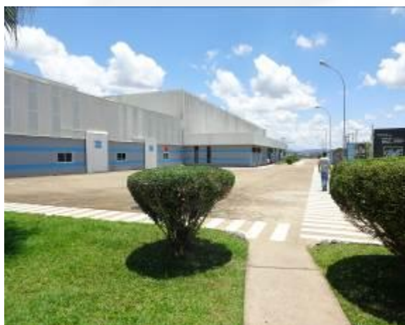
Foto 01. Vista externa do empreendimento.
