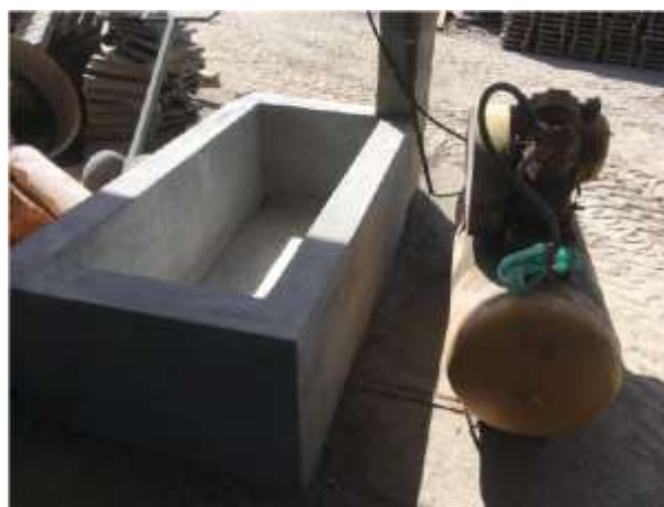
Foto 04. Instalação de bacias de contenção dos compressores.
