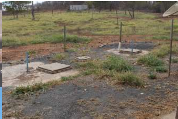
Foto 06. Sistema de tratamento de efluente sanitário (tanque séptico, filtro anaeróbio e sumidouro).
