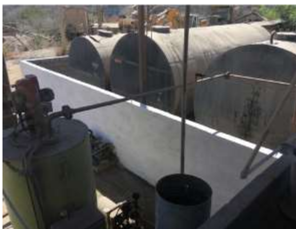
Foto 03. Bacias de contenção na usina de concreto asfáltico.
