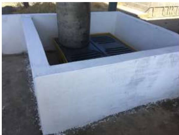
Foto 05. Bacia e palete de contenção para
