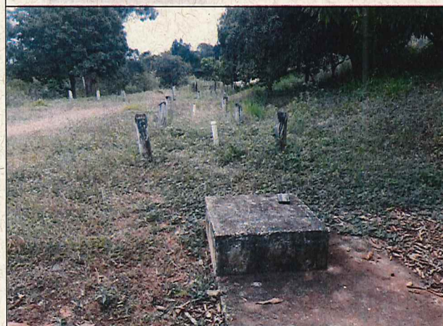
Foto 11: Fossa Séptica (Faz. Caiçara).
