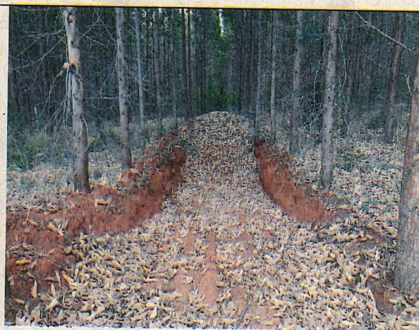
Foto 04: Bacia de Contenção.
