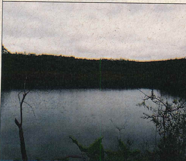
Foto 05: Barramento (Faz. Caiçara).
