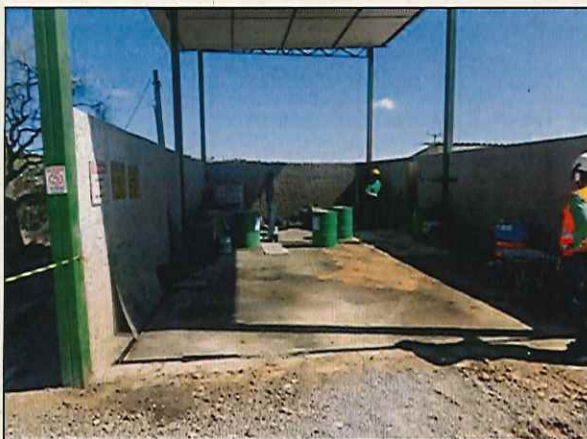
Figura 5: Lavador de Máquinas.
