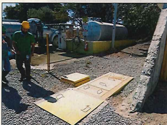
Figura 7: Ponto de abastecimento e caixa SAO nº 2.
