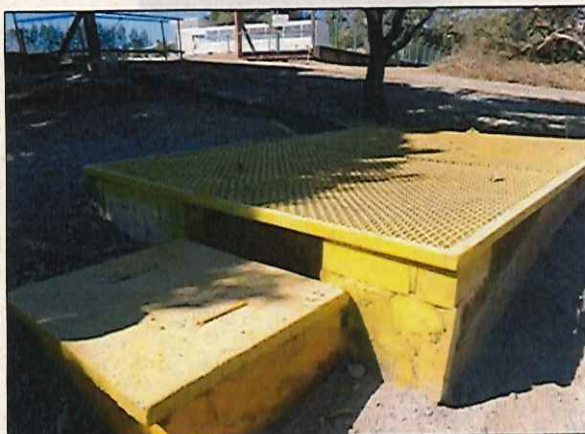
Figura 3: Caixa contenção – drenagem pluvial.
