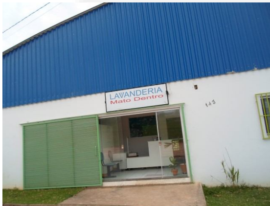
Foto 01. Fachada do empreendimento
